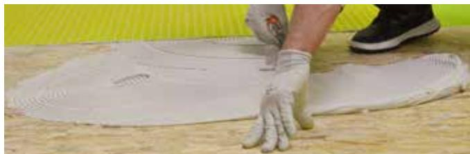
1. Cortar la membrana Floortec antes de la colocación. Extender el adhesivo sobre el soporte.
