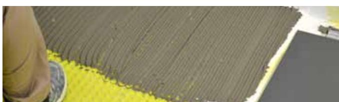
5. Asegurarse de alisar el adhesivo y rellenar completamente las cavidades cilíndricas de la membrana con una llana lisa y posteriormente con una llana dentada idónea.
