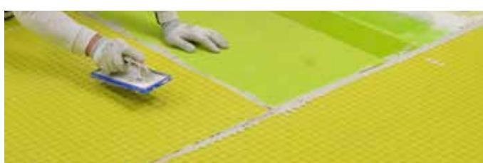
3. Presionar para una correcta fijación de la membrana.
