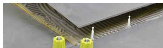
6. Colocar el pavimento. El formato de las baldosas, colocadas exclusivamente con la técnica de "capa llena" (macizado), debe ser de al menos 5x5 cm. Con un soporte de tipo cementoso es aconsejable un adhesivo de tipo C2.
